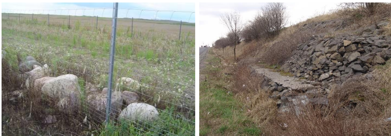
Figura 6. Utilizarea de bolovănișuri ca microhabitat este în măsură a oferi nișe suplimentare ecologice (stânga) și funcționând ca zone de drenaj a apelor de spălare ce contribuie substanțial la stabilizarea pantelor (dreapta)
