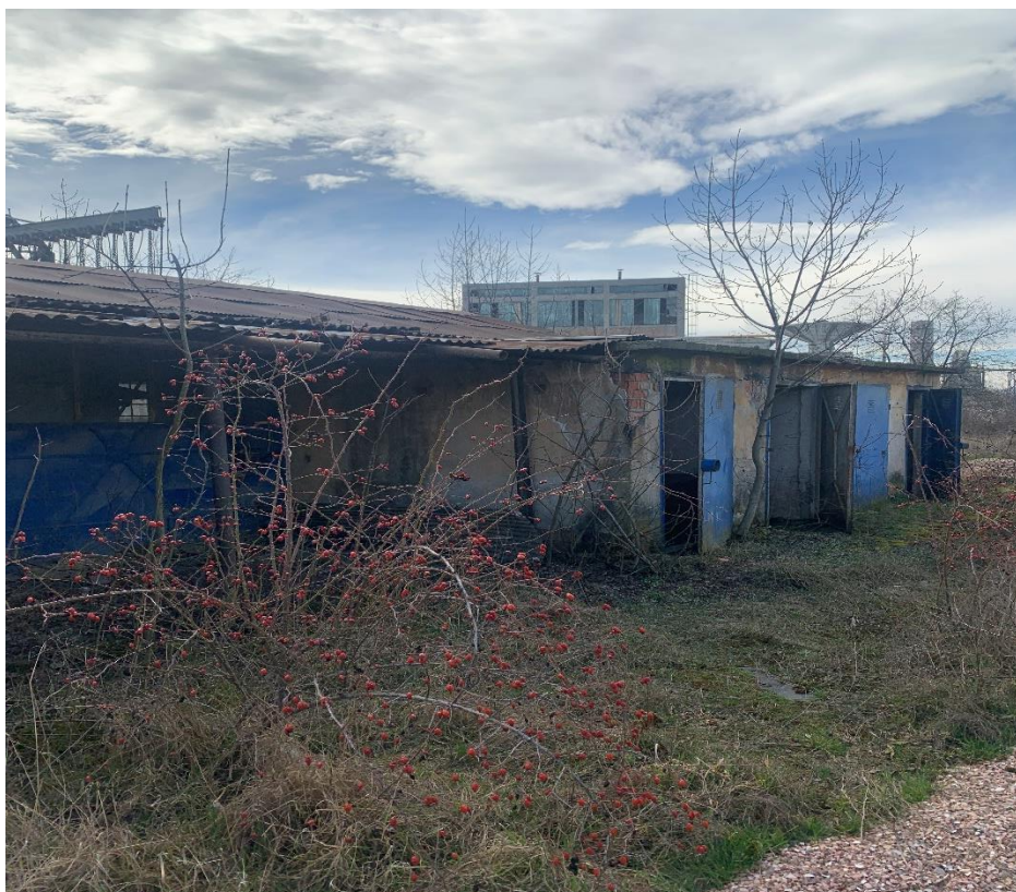
Figura 26 Elemente de pe actuala platformă Sanex
