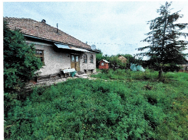
Foto 12. Imobilul (C1) care se demolează
