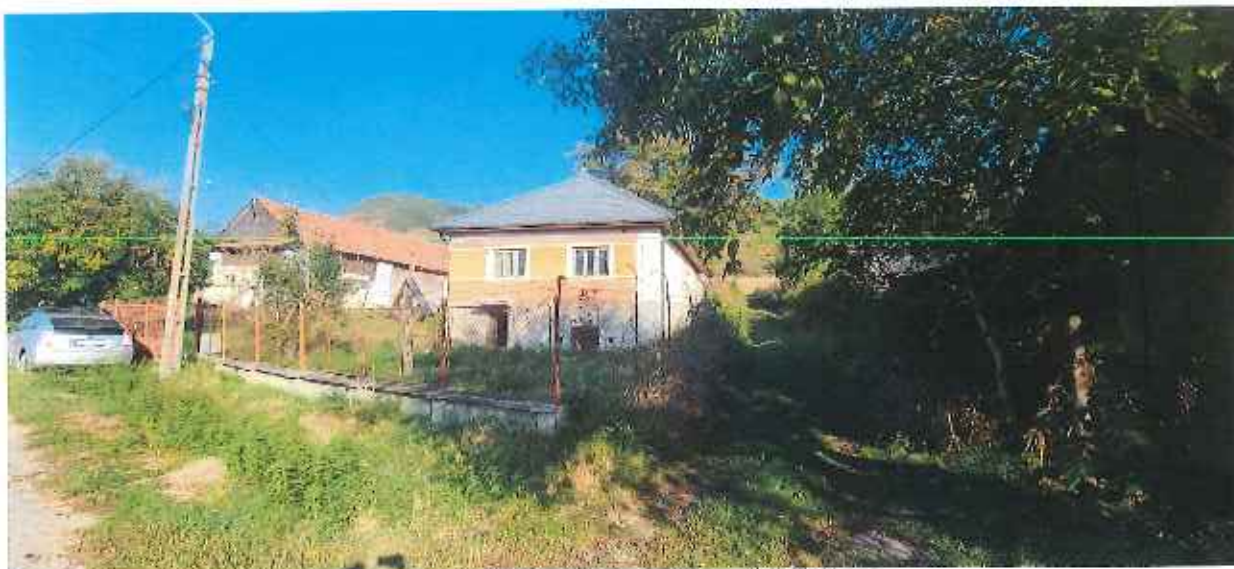
Foto 6. Amplasamentul proiectului (vedere dinspre sud-est, de pe DJ1095).
