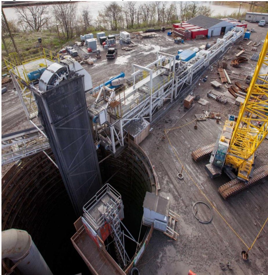
Figura 10.1-9. Transportor cu bandă verticală pentru materialul excavat dintr-un put vertical
