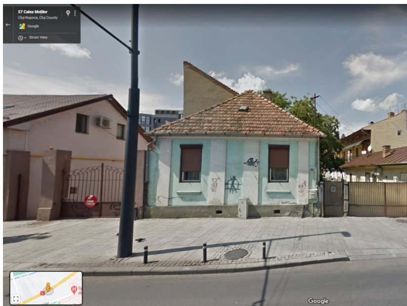
Figura 4.1-7. Amplasament și vedere imobil situat pe Calea Moților nr. 56-58, clădire vest
