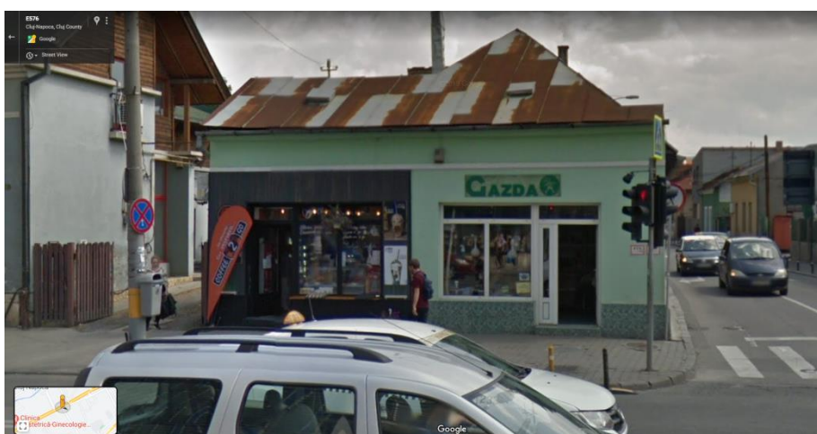
Figura 4.1-11. Amplasament și vedere imobil situat pe B-dul 21 Decembrie 1989 nr. 116, clădire vest
