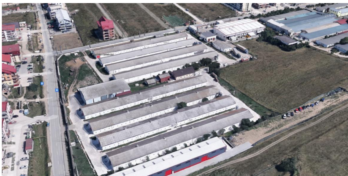
Figura 4.1-2. Amplasament și vedere imobil situat pe Str. Eroilor și Str. Cetății nr. 101-103
