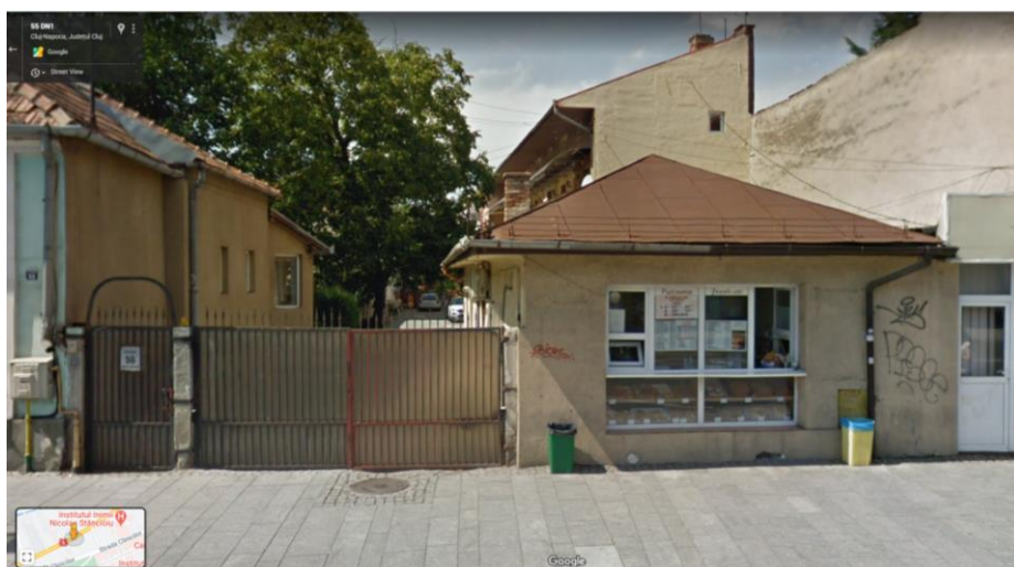
Figura 4.1-8. Amplasament și vedere imobil situat pe Calea Moșilor nr. 56-58, clădire est
