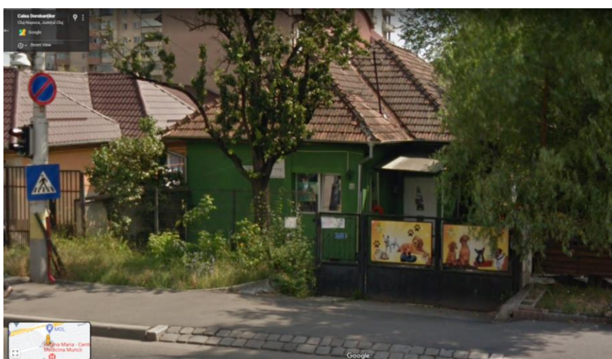
Figura 4.1-15. Amplasament și vedere imobil situat pe Str. Teodor Mihali nr. 13
