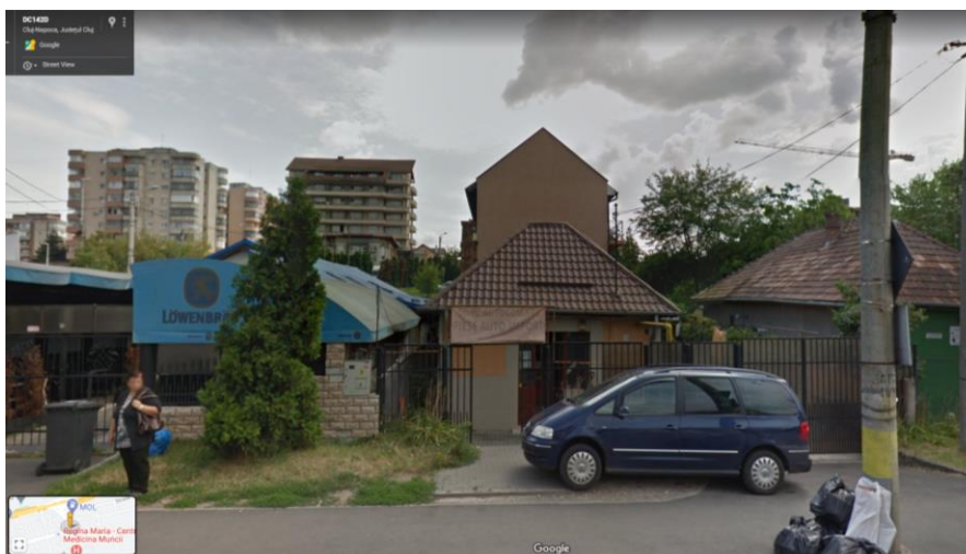
Figura 4.1-14. Amplasament și vedere imobil situat pe Str. Teodor Mihali nr. 11
