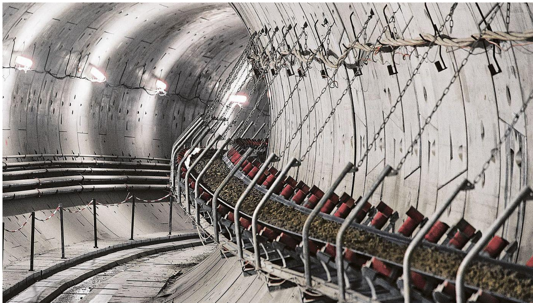
Figura 10.1-8. Transportor cu bandă pentru material excavat în interiorul tunelului
