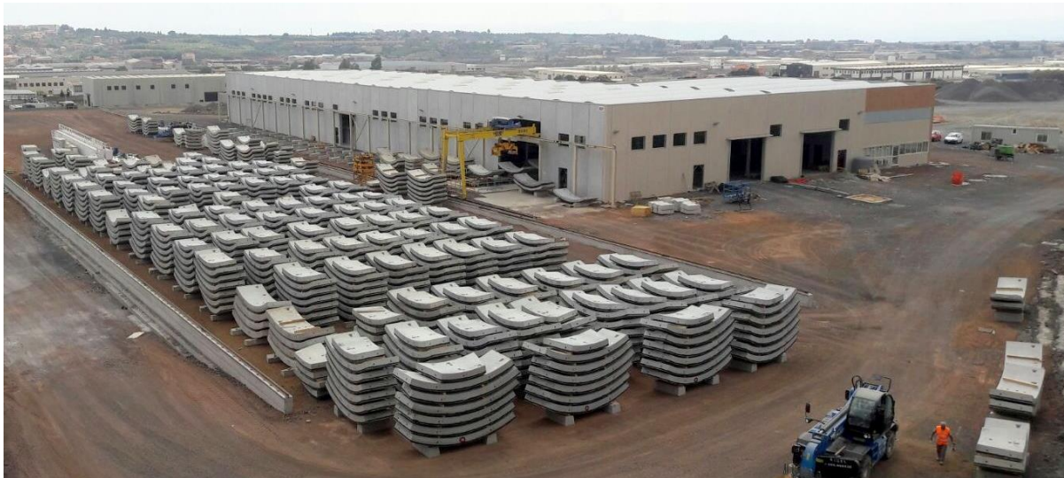
Figura 10.1-4. Zona de depozitare a segmentelor prefabricate de inel.
