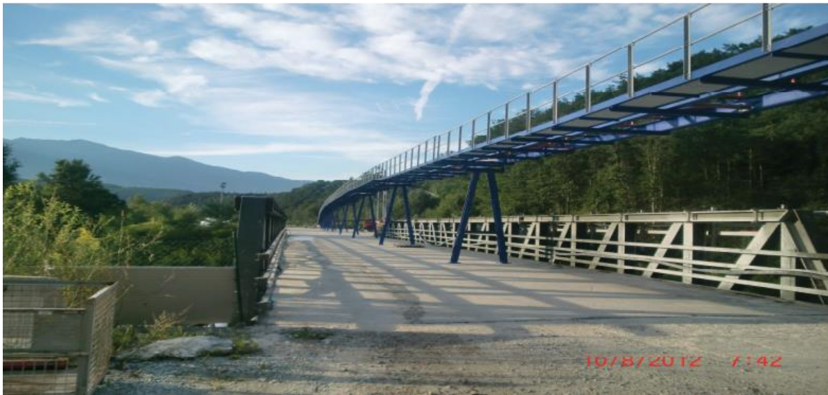
Figura 10.1-7. Transportor cu bandă pentru material excavat în afara tunelului
