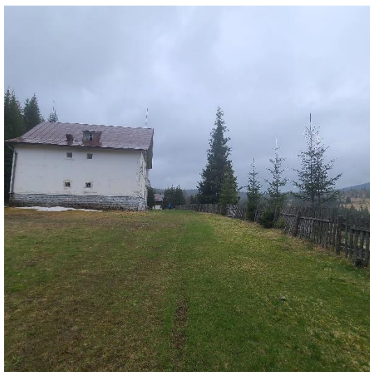
Foto 16. Fațada nordică a imobilului
