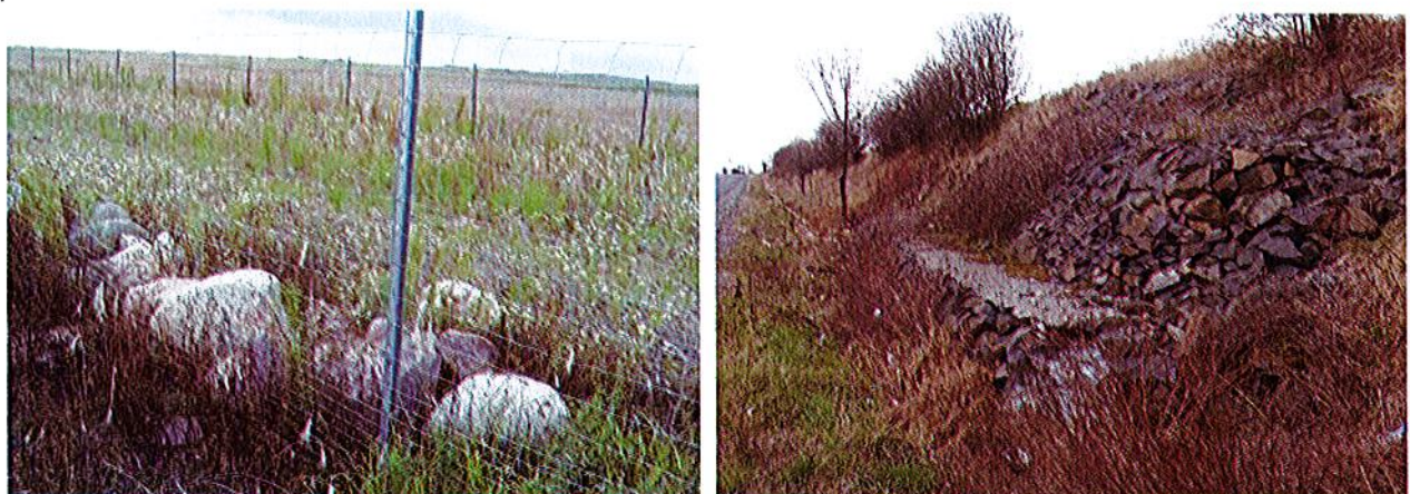
Figura 14. Utilizarea de bolovănișuri ca microhabitate este în măsură a oferi nișe suplimentare ecologice (stânga) și funcționând ca zone de drenaj a apelor de spălare ce contribuie substanțial la stabilizarea pantelor (dreapta)
