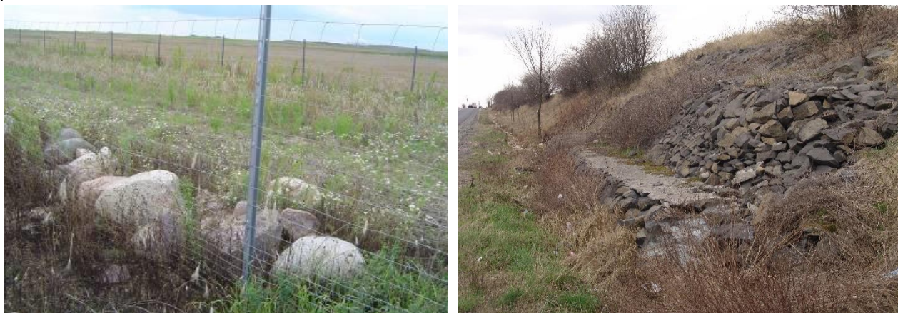
Figura 17. Utilizarea de bolovănișuri ca microhabitate este în măsură a oferi nișe suplimentare ecologice (stânga) și funcționând ca zone de drenaj a apelor de spălare ce contribuie substanțial la stabilizarea pantelor (dreapta)
