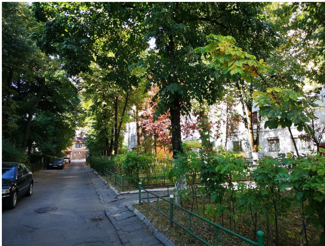
Fig.2 – Borduri si trotuare degradate
