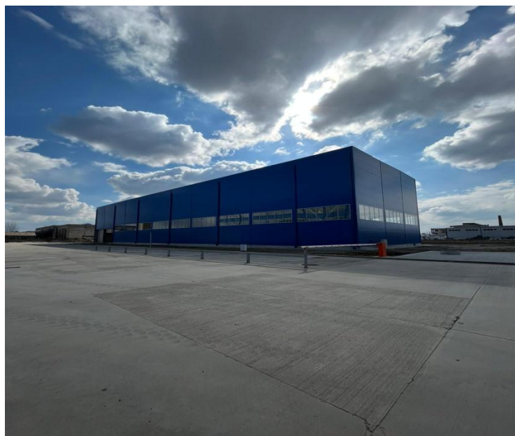
Figura nr. 3 – Depozit piese zincate – Berg Banat S.R.L. Câmpia Turzii
