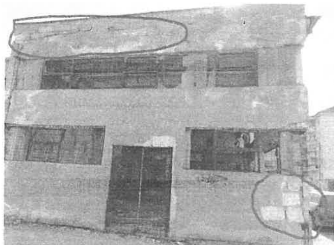
Fațada lateral stânga. Zidărie exterioară BCA
