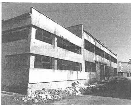
Fațadă lateral dreapta
