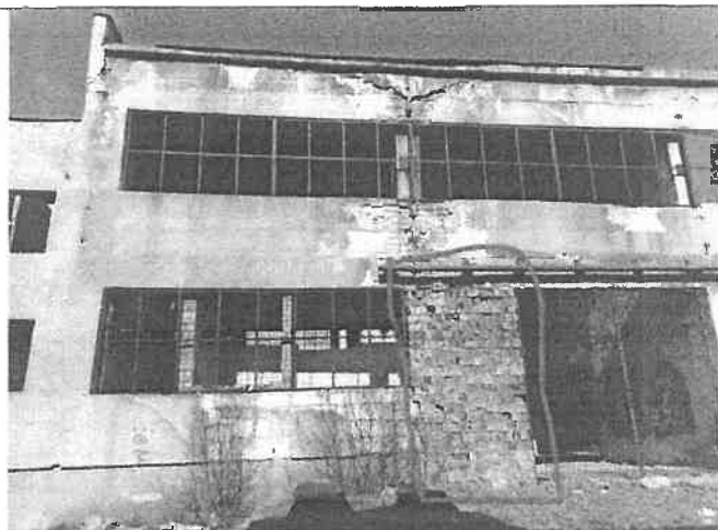
Fațada lateral dreapta. Zidărie exterioară cărămidă plină
