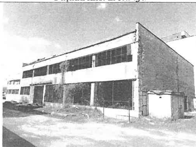
Fațadă lateral dreapta și posterioară
