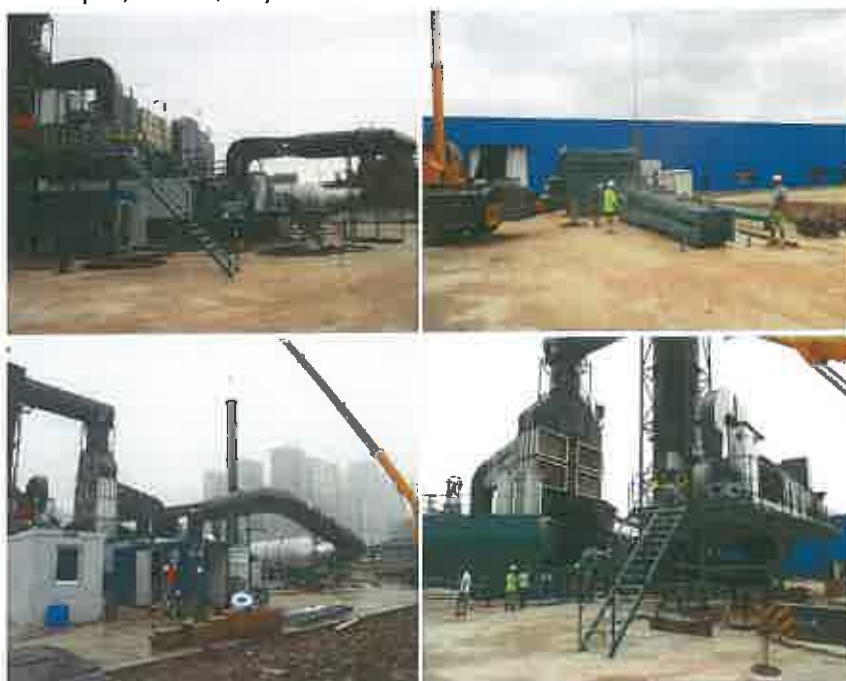
Figura 7. Aspecte din etapa de montaj a instalației de desorbție termică Savaterra
