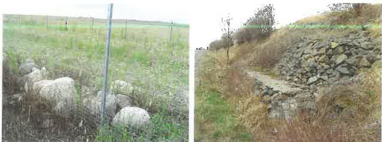
Figura 45. Utilizarea de bolovănișuri ca microhabitate este în măsură a oferi nișe suplimentare ecologice (stânga) și funcționând ca zone de drenaj a apelor de spălare ce contribuie substanțial la stabilizarea pantelor (dreapta)
