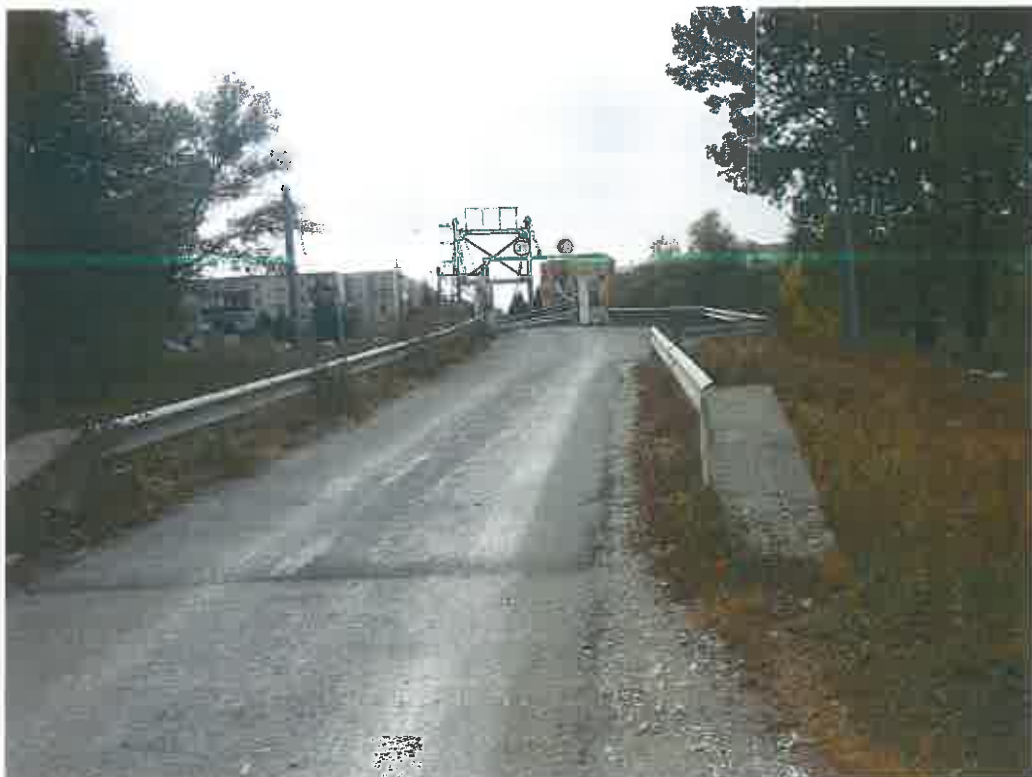
Figura 41. Aspectul la amplasament pe podul ce traversează râul Arieș
