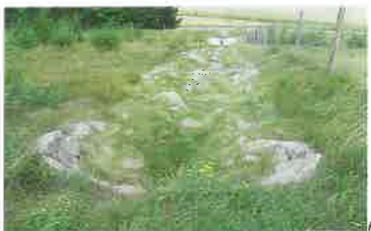
Planșa 1. Aplicații ale unor structuri de tipul rigolelor înierbate și a bazinelor temporare
