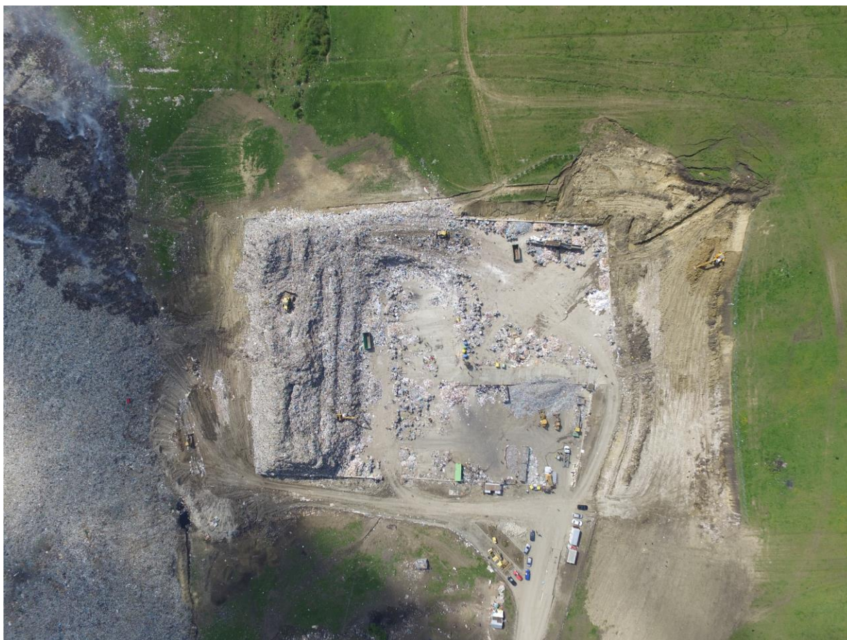
Figura 1. Imagine de ansamblu a amplasamentului în relație cu depozitul de deșeuri de la Pata Rât (în partea stângă)
