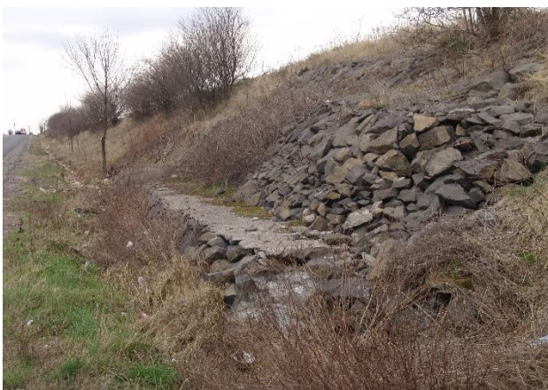
Figura 6. Utilizarea de bolovănișuri ca microhabitate este în măsură a oferi nișe suplimentare ecologice (stânga) și funcționând ca zone de drenaj a apelor de spălare ce contribuie substanțial la stabilizarea pantelor (dreapta)
